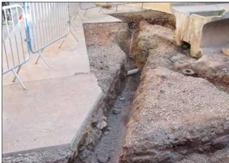
Travaux rue du Mas de Fustier : Renouvellement de 5 branchements d'eau potable
