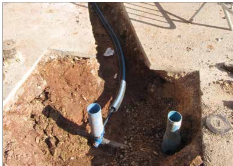
Travaux rue du Mas de Fustier : Renouvellement de 5 branchements d'eau potable
