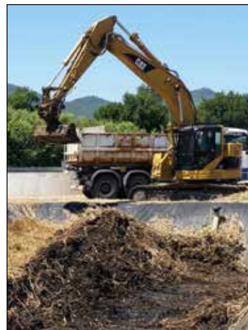
Curage du lit de séchage planté de roseaux n°1 Crédit Photo : Alliance Environnement
